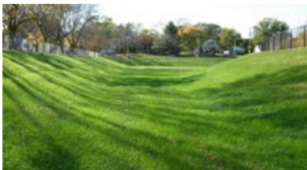
Figura 29. Estanque de detención en el parque Grandview, Waukesha, Wisconsin (Estados Unidos). Fuente. Volkening, 2010c, 2010b.
