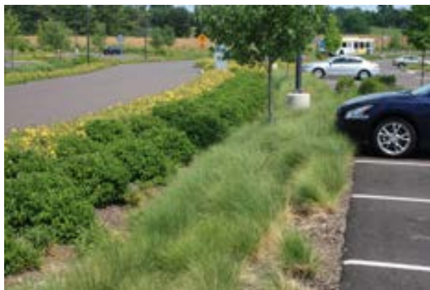
Figura 77. Zanjas de infiltración en estacionamiento de un hospital en Montgomery, Pensilvania (Estados Unidos).
