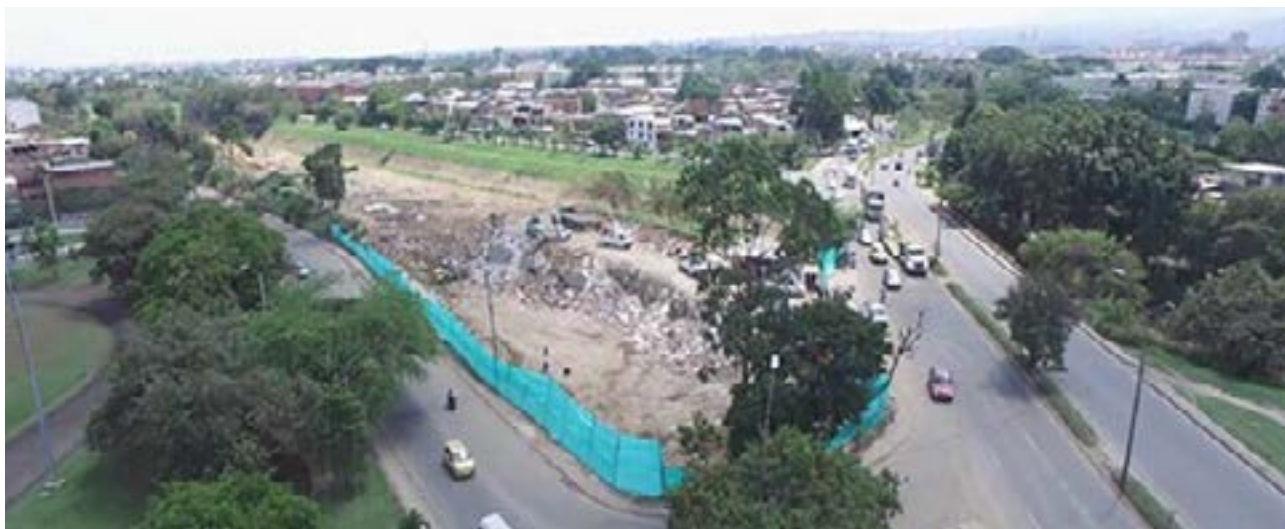
Figura 3. Descolmatación EDT Carrera 50 en Santiago de Cali. Fuente: Alcaldía de Santiago de Cali, 2019.
