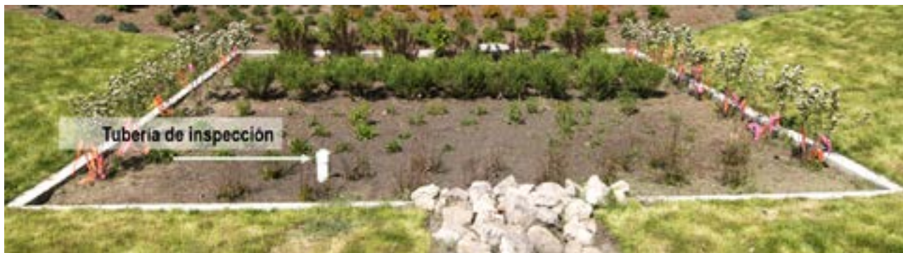
Figura 38. Tubería de inspección en jardín de biorretención en Detroit, Michigan (Estados Unidos). Fuente. University of Michigan School for Environment and Sustainability, 2016.
