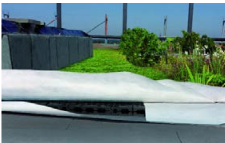
Figura 7. Construcción de cubierta reguladoras de aguas de lluvia. Fuente: The latest press releases | ZinCo Green Roof Systems, s. f.
