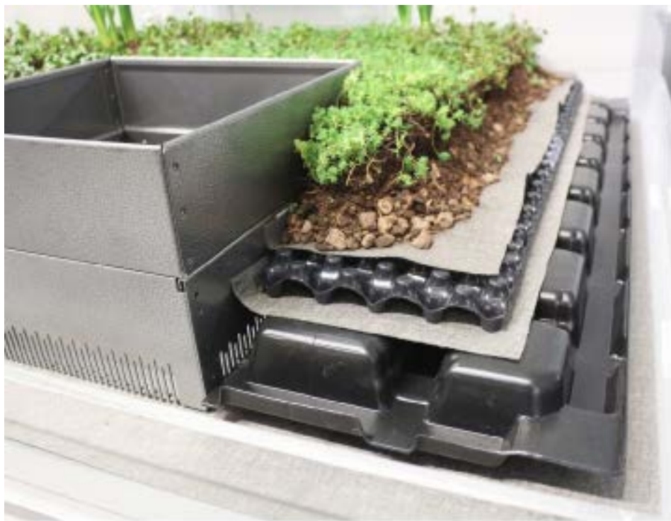
Figura27. Sección Fotográfica Cubierta Vegetada Reguladora de Cargas Pluviales. Fuente: (ZinCo Green Roofs | Biodiversity Roofs, s. f.)
