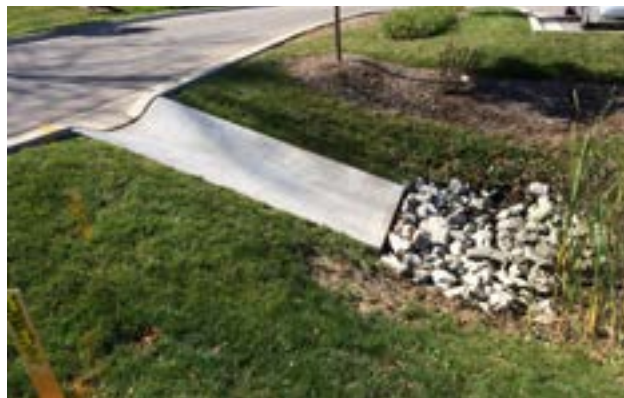
Figura 19. Vado a la entrada de una estructura de detención. Fuente. Volkening, 2014a.
