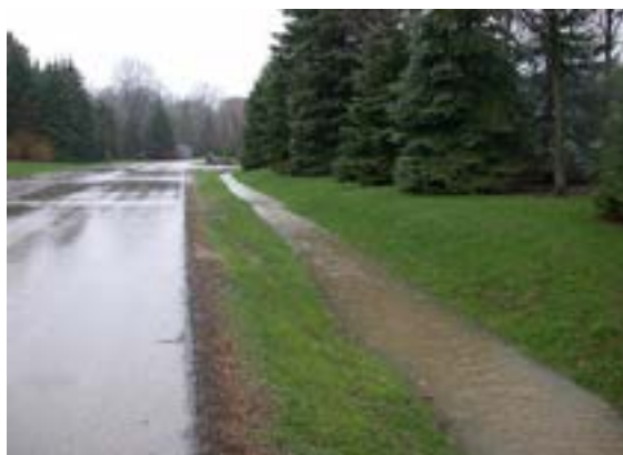
Figura 22. Canal vegetado en Greenfield, Wisconsin (Estados Unidos). Fuente. Volkering, 2014c.
