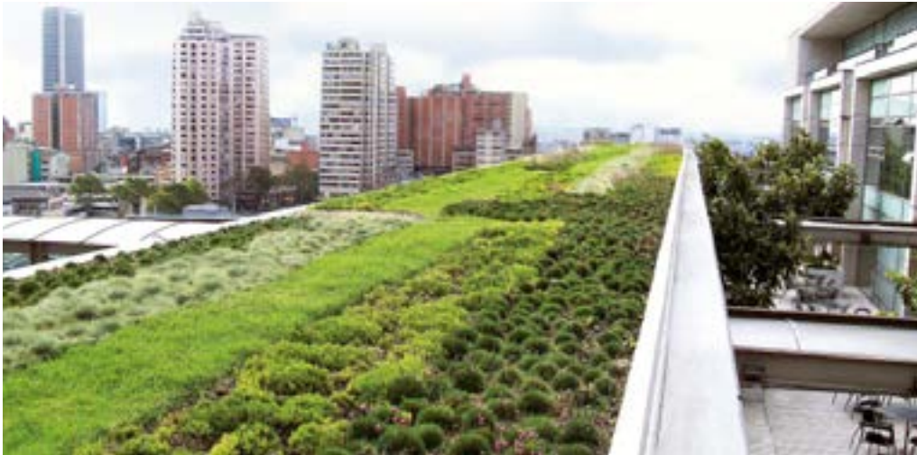
Figura 8. Cubierta Vegetada para climatización urbana.
