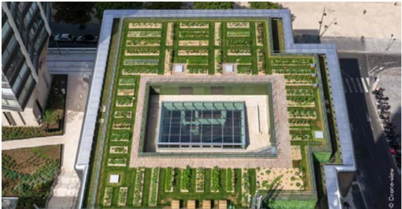
Figura 11. Cubierta huerta urbana. Fuente: Le Cordon Bleu, Paris | ZinCo Green Roof Systems, s. f.
