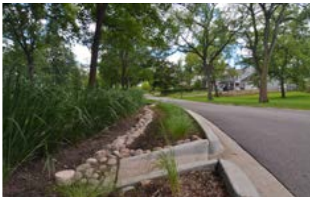
Figura 18. Vado con bordillos laterales en un jardín de biorretención. Fuente. Center for Neighborhood Technology, 2014.
