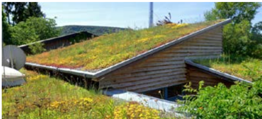
Figura 3. Cubiertas extensivas planas e inclinadas. Fuente: Extensive Green Roof Sedum Carpet | ZinCo Green Roof Systems, s. f.
