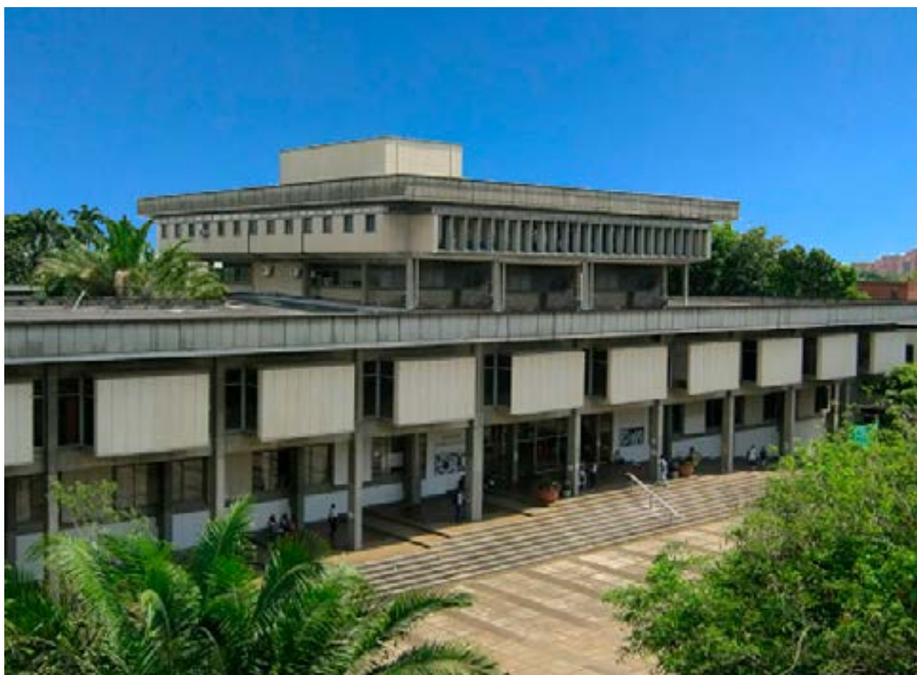
Figura 8. Elementos de protección solar en vanos y circulaciones incluidos en la arquitectura. Biblioteca Mario Carvajal Biblioteca Mario Carvajal, arquitecto: Bruno Violi, Universidad del Valle, Meléndez. Fuente: edición de Hugo Alegría L.
