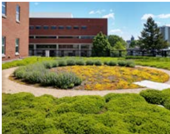
Figura 73. Cubierta verde en la Universidad Estatal de Ohio. Fuente: Keck, 2019.
