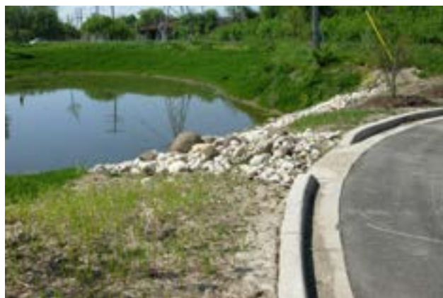
Figura 34. Vado con enrocado como entrada a un estanque de detención en Brown Deer, Wisconsin (Estados Unidos). Fuente. Volkening, 2014b.
