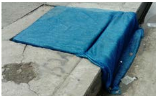
Figura 13. Protección de sumidero con geotextil. Fuente: https://www.setri.com.co/wp/wp-content/uploads/2019/05/proteccion-carcamos-y-sumideros.jpg
