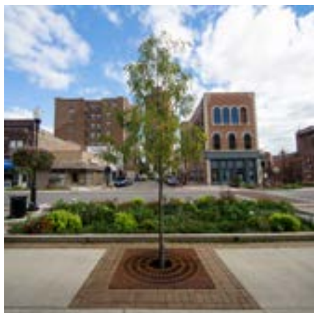
Figura 20. Alcorque ubicado junto a un jardín de biorretención en Aurora, Illinois (Estados Unidos) Fuente. Center for Neighborhood Technology, 2015.
