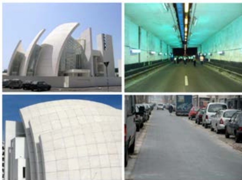
Figura 19. Edificaciones e infraestructura con concretos y morteros con capacidad de auto-limpieza y purificación del aire.
