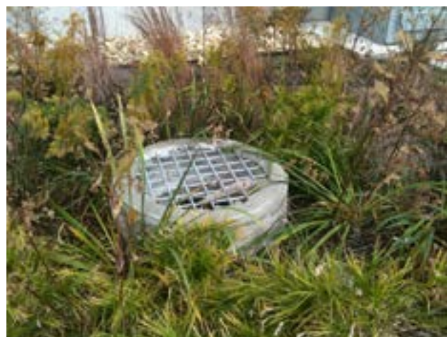
Figura 37. Estructura de rebose de un jardín de biorretención en Milwaukee, Wisconsin (Estados Unidos).
