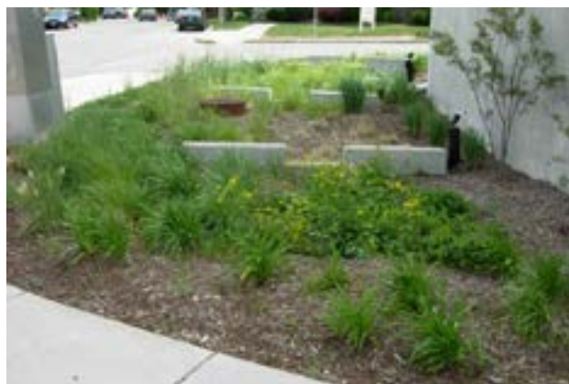
Figura 35. Barreras de detención localizadas en un canal vegetado en Milwaukee, Wisconsin (Estados Unidos). Fuente. Volkening, 2012b.
