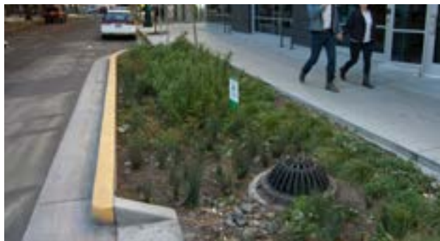
Figura 24. Jardín de biorretención localizado en una extensión de la acera. Fuente. Boskybiscuit, 2012.
