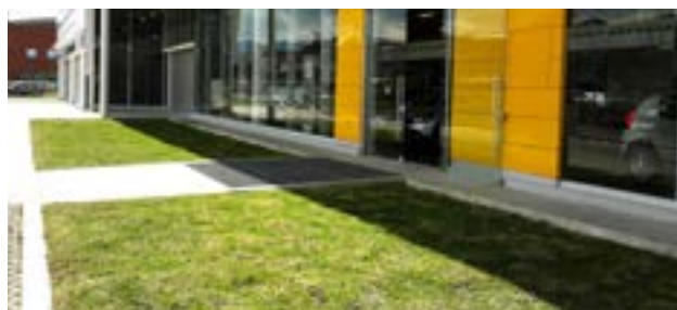
Figura 46. Ejemplos de capas superiores filtrantes de los sistemas de pavimentos permeables: eco-pavimento con ladrillo triturado (izq.), y grama (der.). Fuente. Cortesía de Helechos S.A.S
