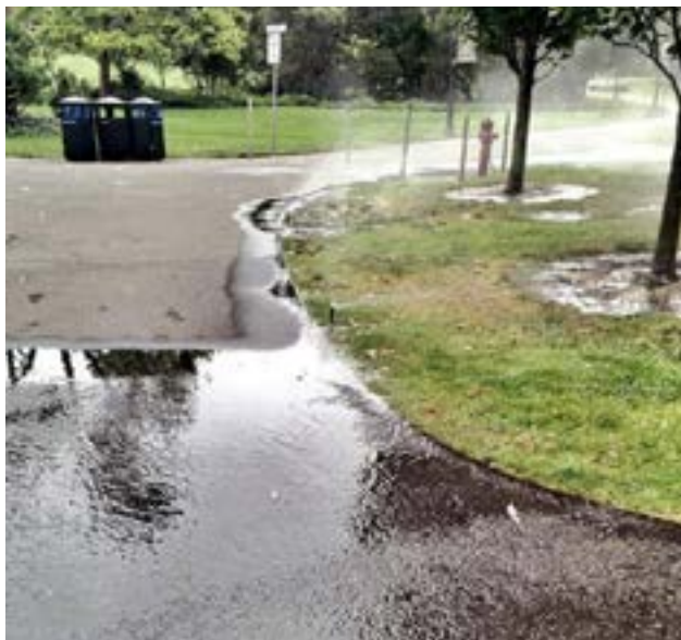
Figura 29. Ejemplo de pérdida de agua de riego por escorrentía por áreas vegetadas no limitadas de las áreas impermeables. Fuente: https://www.berkeleyside.com/wp-content/uploads/2014/07/image.jpeg
