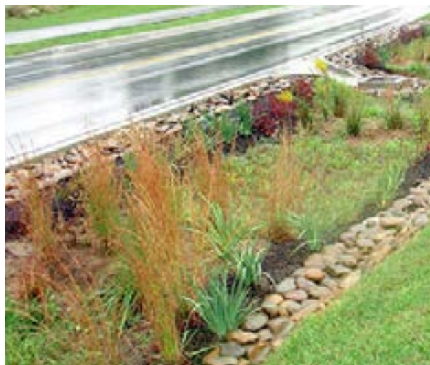
Figura 30. Ejemplo de jardín delimitado de las áreas impermeables para reducción de escorrentías, jardín de infiltración. Fuente: https://www.vioxinc.com/wp-content/uploads/2019/01/img_secondary-hero-project-weatherington-blvd-bioswales.jpg
