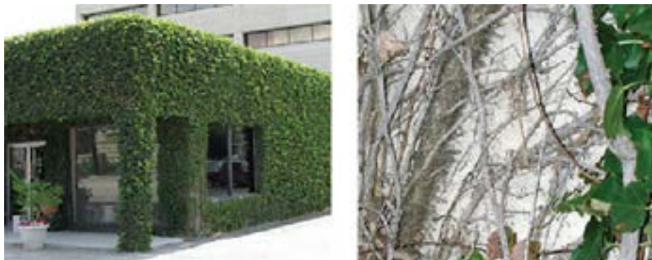
Figura 12. Enredadera se adhiere a un edificio usando ventosas adhesivas agresivas o raíces trepadoras que pueden dañar las superficies y entrar en huecos y grietas. Fuente: greenscreen® – an innovative and unique modular trellising system, s. f.
