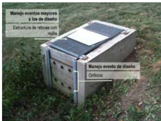
Figura 36. Sistema de salida de un estanque de detención localizado en el parque Ambruster en Greendale (Wisconsin, Estados Unidos).
