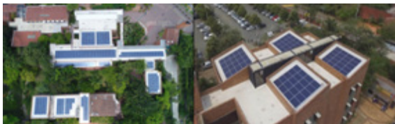
Edificio de Acacias y Edificio Administrativo con instalación del sistema solar fotovoltaico.
