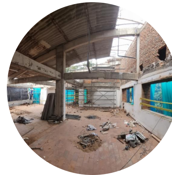
Reforzamiento Edificio Administrativo
